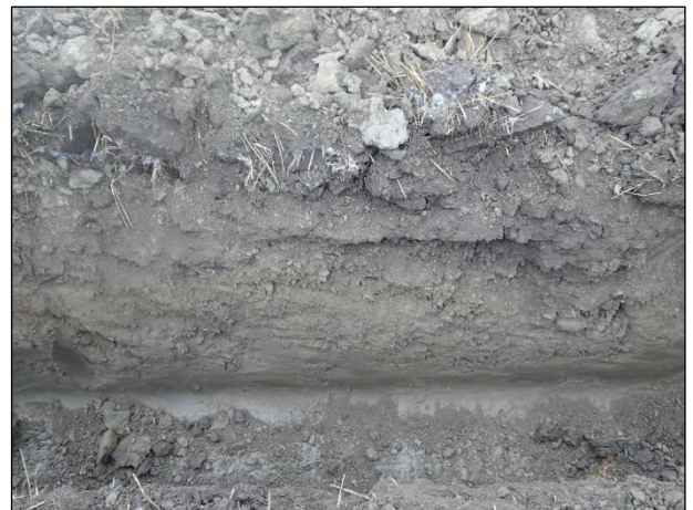
Vasen: Maakaapelikaivantoa Vanajan vanhan pappilan ja Rautaruukintien välisellä peltoalueella. Oikea: Kaivannon seinämää, ylinnä normaali muokkauskerros ja sen alla luontainen hiesu.
