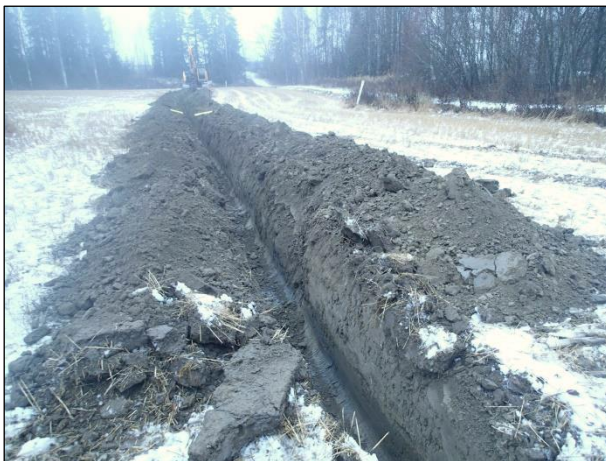
Vasen: Maakaapelikaivantoa Vanajan vanhan pappilan ja Rautaruukintien välisellä peltoalueella. Oikea: Kaivannon seinämää, ylinnä normaali muokkauskerros ja sen alla luontainen hiesu.
